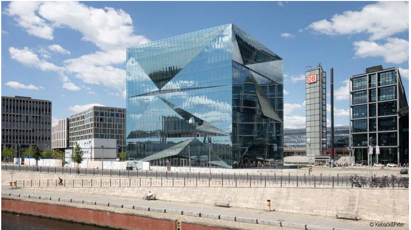
Der cube berlin ist das derzeit wahrscheinlich intelligenteste Bürogebäude Europas. The cube berlin is currently probably the most intelligent office building in Europe.
